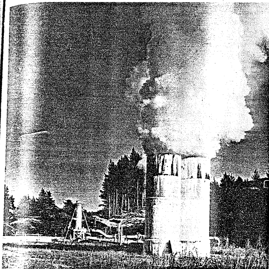
A Wairakei, dans la province d'Auckland, en Nouvelle-Zélande, un puits générateur de vapeur muni d'un pot d'échappement et d'un même dispositif doublé d'un séparateur de vapeur (ci-dessous).
